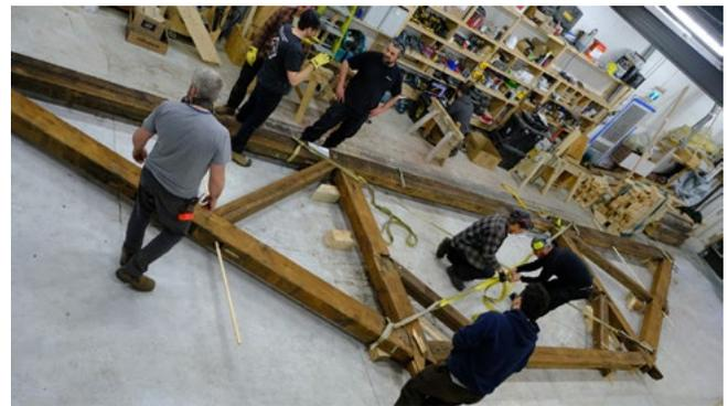
*Charpente originale placée au sol pour tracer l'épure.*
