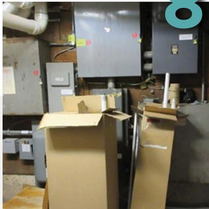
Des boîtes de carton sont entreposées près des panneaux électriques. Les normes de sécurité incendie exigent un dégagement d'un minimum d'un mètre devant les panneaux électrique ou autre équipement électrique comme des transformateurs. De plus, la Mutuelle demande que les locaux électriques et les chambres de fournaies ne servent pas d'entrepôt.
