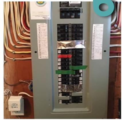
Du ruban adhésif est utilisé pour maintenir le disjoncteur ouvert ou pour cacher les disjoncteurs manquants. Aucun ruban adhésif ne doit être utilisé pour empêcher un disjoncteur de se déclencher en cas de survoltage ou pour cacher un casier de métal sur le panneau électrique.
