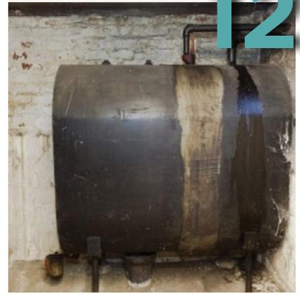
Les raccords du réservoir de mazout (huile à chauffage) sont défectueux. Une réparation urgente doit être faite par un professionnel.
