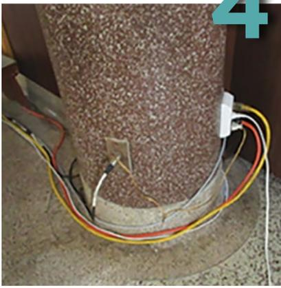
L'utilisation d'une multiprise sans disjoncteur est fortement décommandée, car si les branchements sont sollicités en même temps, cela peut endommager le filage et le circuit électrique et possiblement occasionner un incendie (surtout sur dans le cas de vieilles installations).
