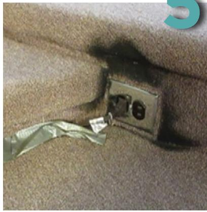
La prise électrique recouverte de tapis a déjà surchauffé et elle alimente encore une rallonge électrique. La prise de courant doit être remplacée et dégagée du recouvrement de tapis.
