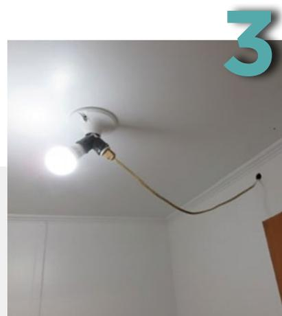
Un adaptateur électrique de lampe simple a été installé pour brancher une rallonge électrique supplémentaire (modèle cordon tout usage) en permanence. Cette dernière n'est pas conçue pour alimenter en électricité des appareils ou de l'éclairage en permanence.
