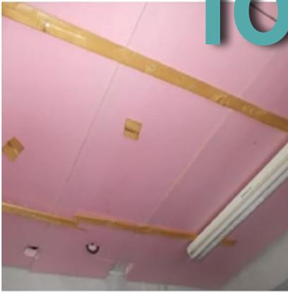
Le plafond a été isolé avec des panneaux en polystyrène (souvent appelés styromousse). Un néon électrique est installé presque directement sur le polystyrène.
